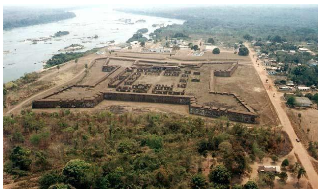
Figura 02 - O Real Forte do Príncipe da Beira com vista parcial do Rio Guaporé
